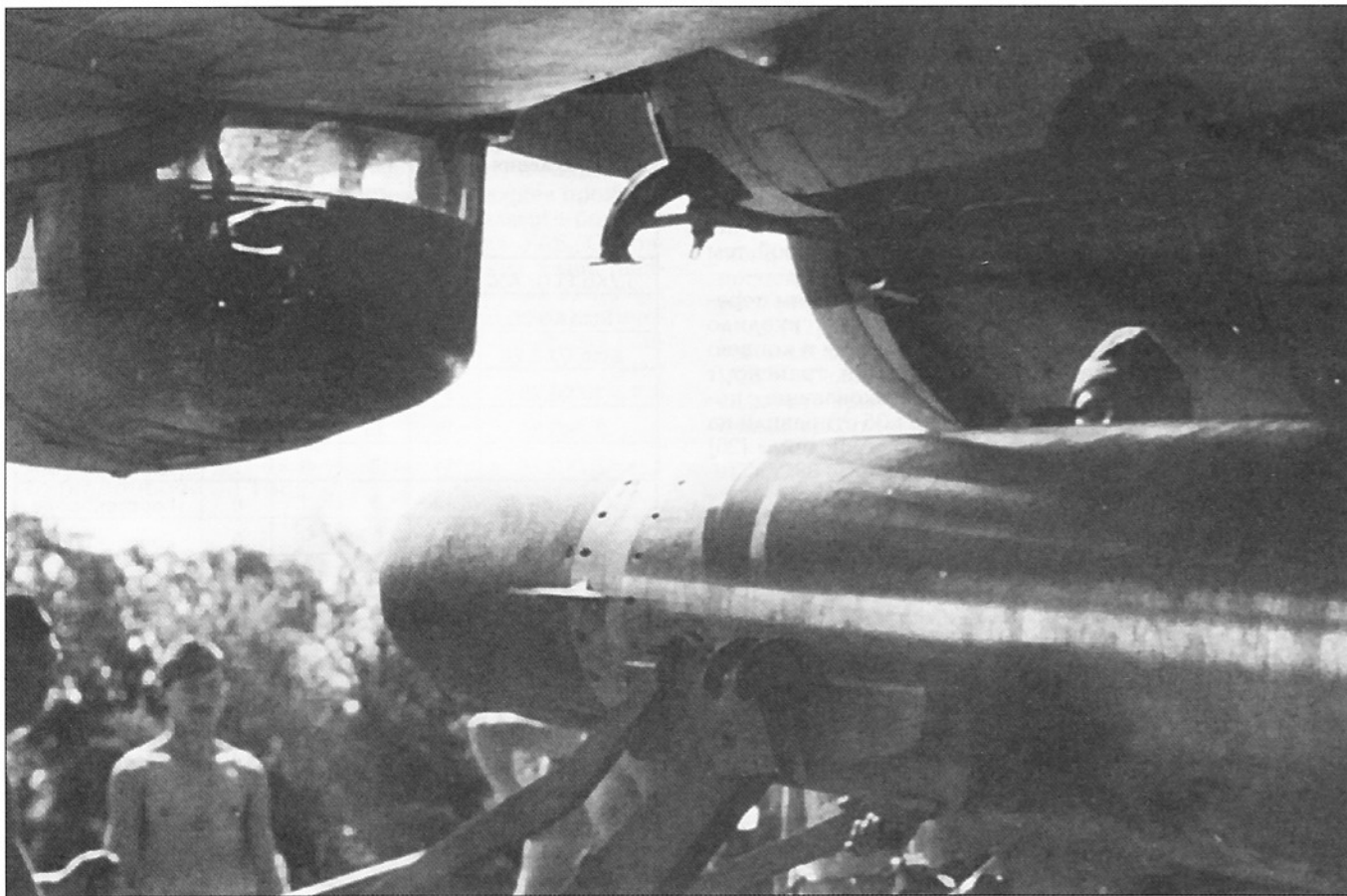
Подвеска 750-кг торпеды F5b на пилон РВС самолета Ju 88А-4/Торп
