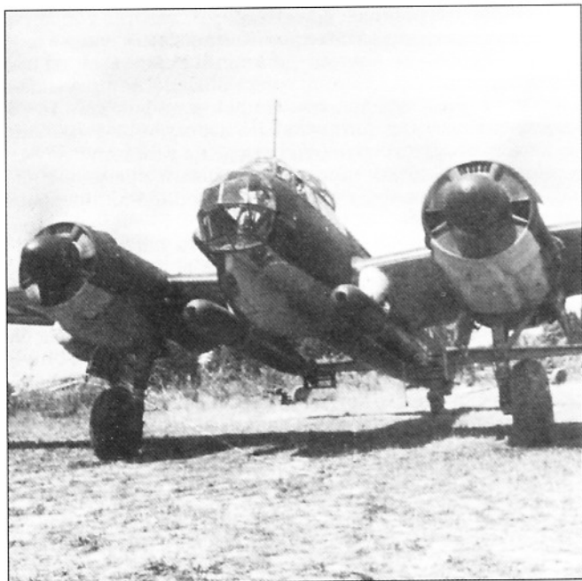
Торпедоносец Ju 88A-4/Torp (модификация бомбардировщика Ju 88A-4) с ракетными ускорителями Walter
