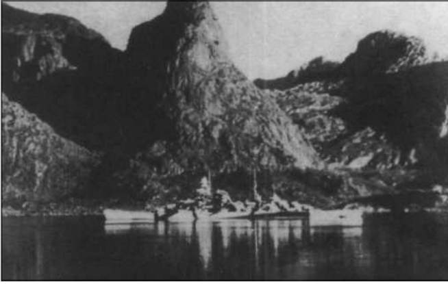
«Адмирал Хиппер» на якоре в норвежском фьорде, 1942 г. Носовая и кормовая оконечности корпуса окрашены в светло-серый цвет, средняя часть корпуса - средне-серый цвет. Такая окраска делала корабль менее заметным в открытом море, но не фоне гор.
