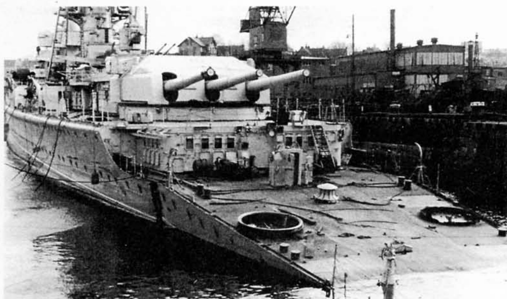
Надломившаяся в результате торпедного попадания корма "Лютцова". На нижнем снимке видны мелкие повреждения, причиненные норвежской береговой артиллерией.
